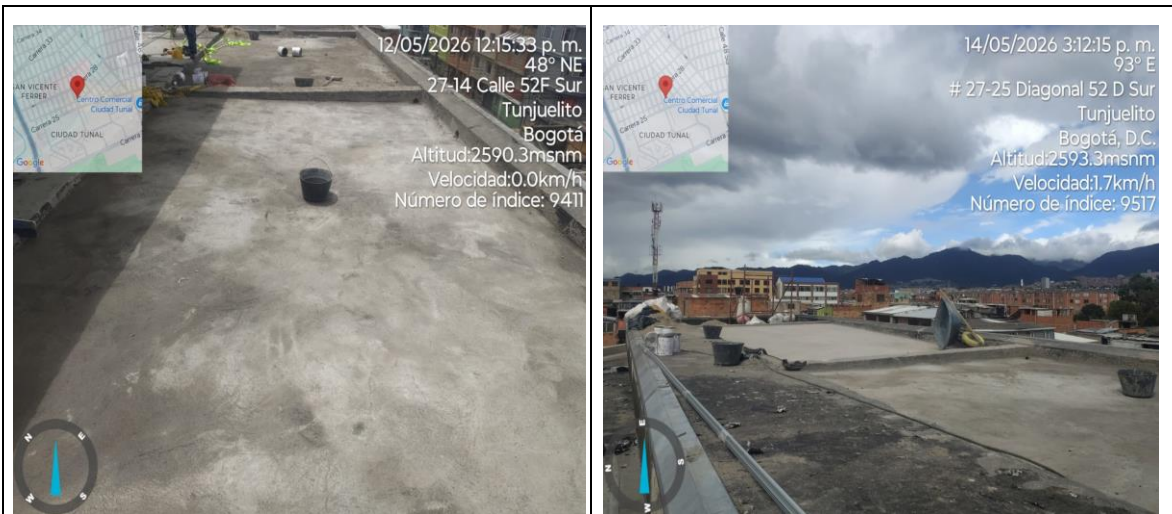
Nivelación con mortero en cubierta para posterior instalación del manto
